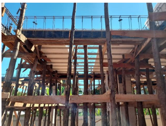
Figura 9 – Execução de Laje Pré-Moldada
