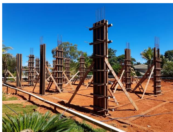
Figura 12 – Utilização de Travamentos Metálicos
