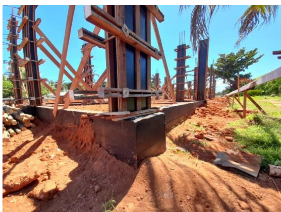
Figura 11 – Utilização de Travamentos Metálicos
