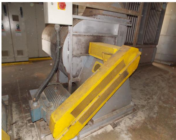
Figura 3-4 - Ventilador recirculação.
