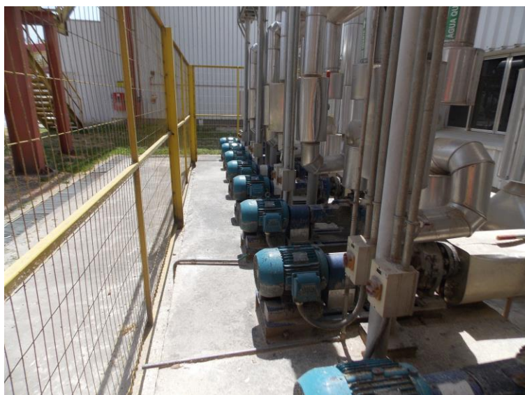
Figura 3-16 - Conjunto bomba aquecedor.
