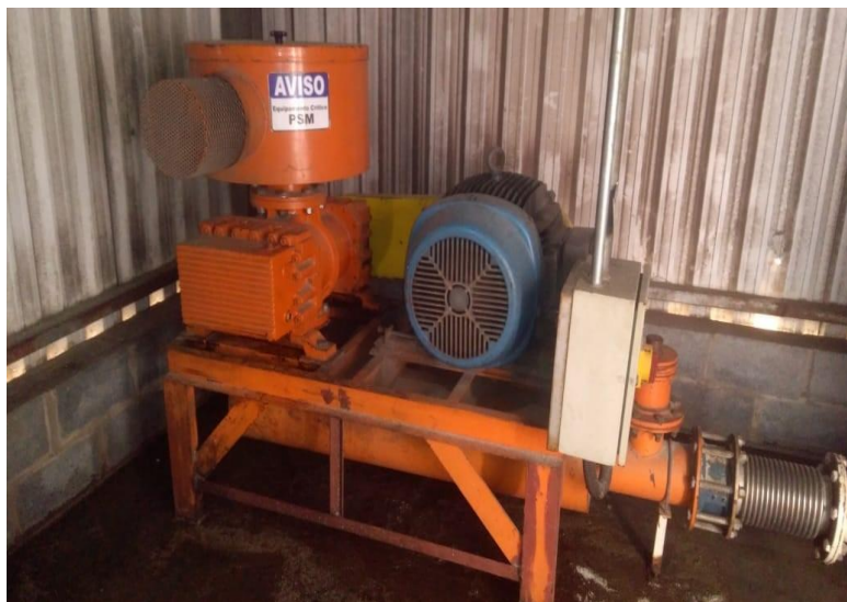
Figura 3-17 - Soprador EX-4020.
