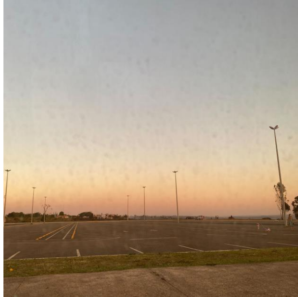
Figura 9: foto do estacionamento da torre digital de Brasília durante a pandemia
