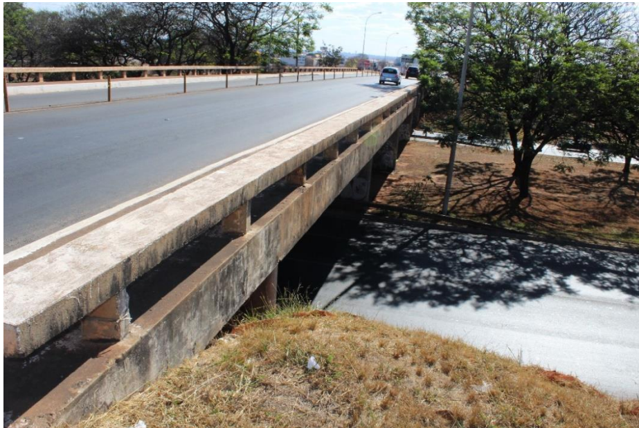
Figura 4.3 - Foto panorâmica do Viaduto sobre a DF-003 acesso ao SIA
