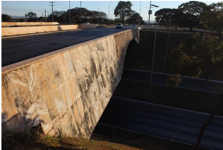
Figura 4.10 - Foto panorâmica do Viaduto 1 - SPS (Próximo a DF-003 E Ao Cruzeiro)
