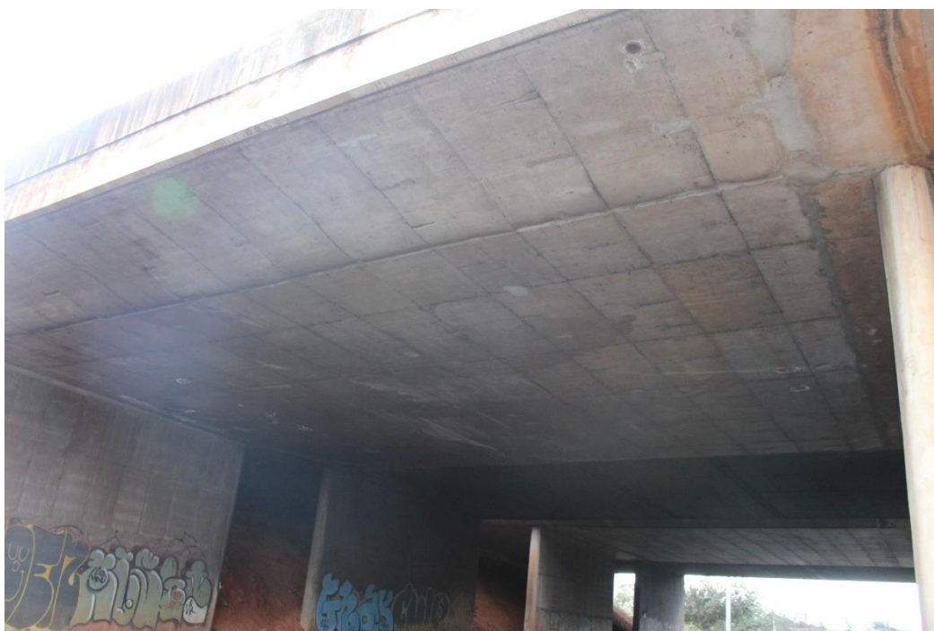
Figura 4.7 - Viaduto 4 sobre a DF-003 acesso ao Guará
