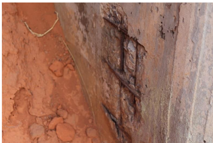
Figura 2.6 - Exemplo do processo de correção - Viaduto sobre a DF-003 acesso ao SIA
