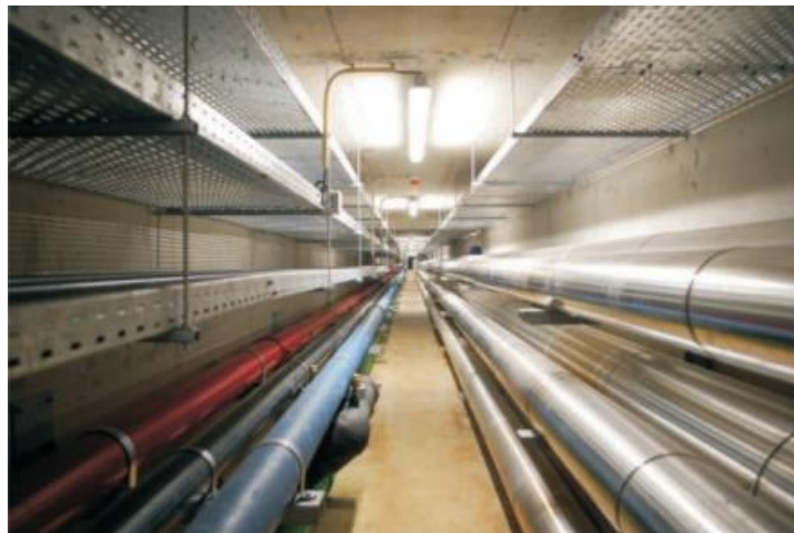
Figura 3.11: Exemplo de galeria técnica (COPEL, 2010)
