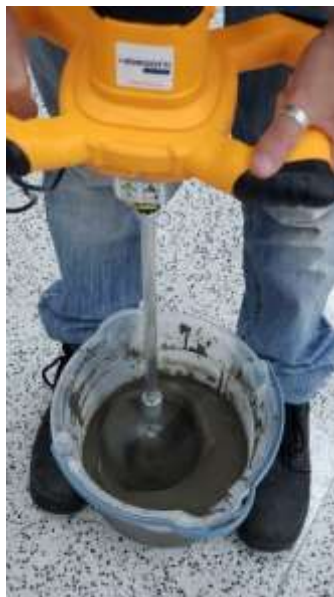
Figura 15 - Processo de mistura da pasta.
