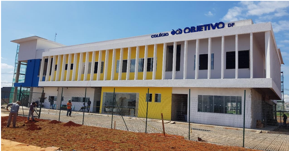
Figura 34. Edificação em estudo executada e ocupada pelo Colégio Objetivo. (PROEST, 2020).
