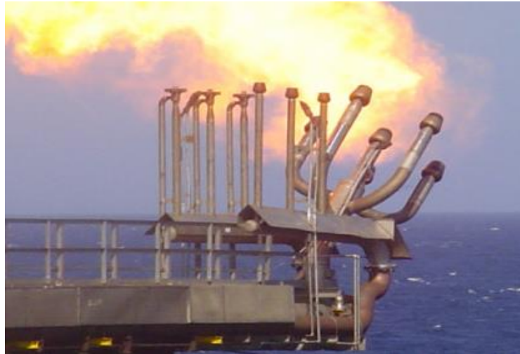
Figura 5: Flare multiponto com tulipa móvel.
