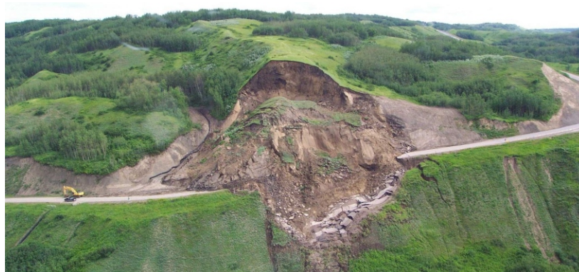
Figura 5 – Escorregamento de um talude
