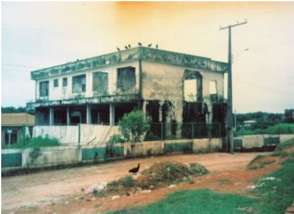
Foto 13: Imagem de uma obra abandonada no centro de Tefé.
