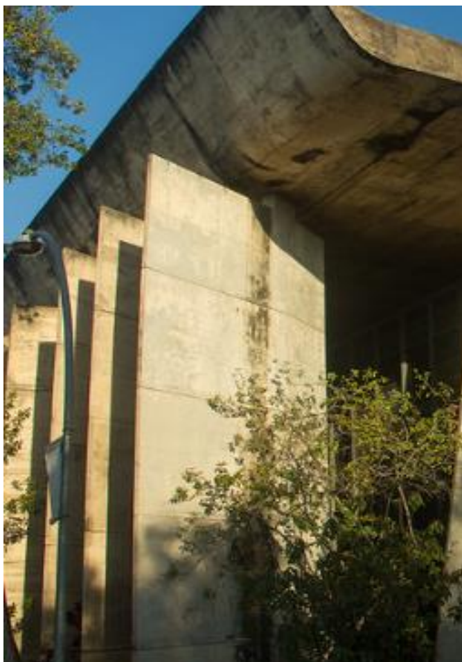
Figura 8. Brise-soleils em folhas de concreto na Biblioteca Central da Universidade de Brasília
