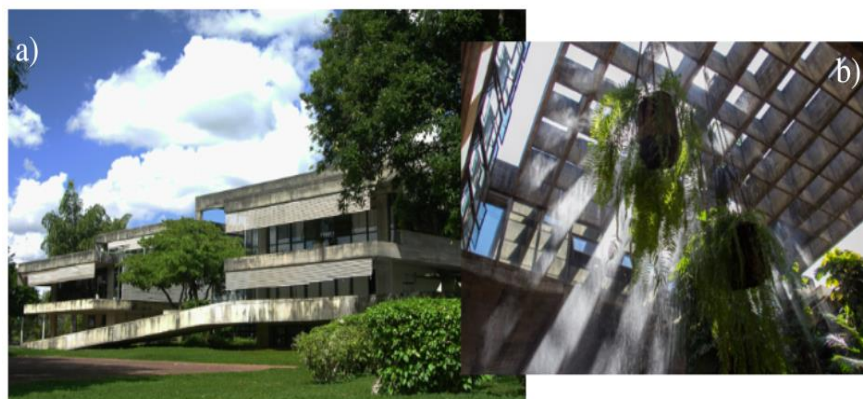
Figura 12. a) Prédio da Reitoria da Universidade de Brasília; b) Iluminação Zenital em grelha reticulada na Reitoria da Universidade de Brasília
