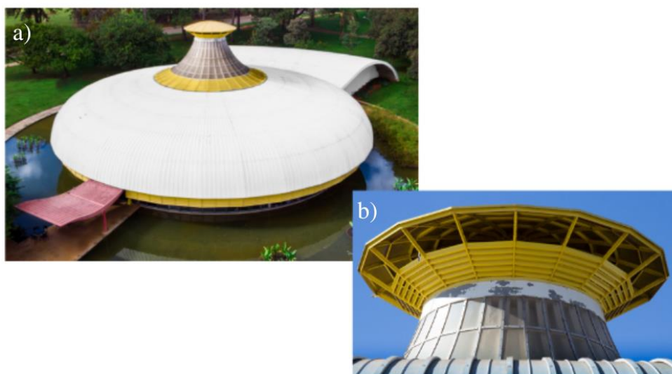
Figura 13. a) Telhado em forma de oca que favorece a iluminação e ventilação natural no Memorial Darcy Ribeiro da Universidade de Brasília; b) Dispositivo shed no topo do telhado do Memorial Darcy Ribeiro da Universidade de Brasília
