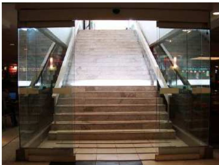
Figura 32 - Escada fechada com porta de vidro automática
