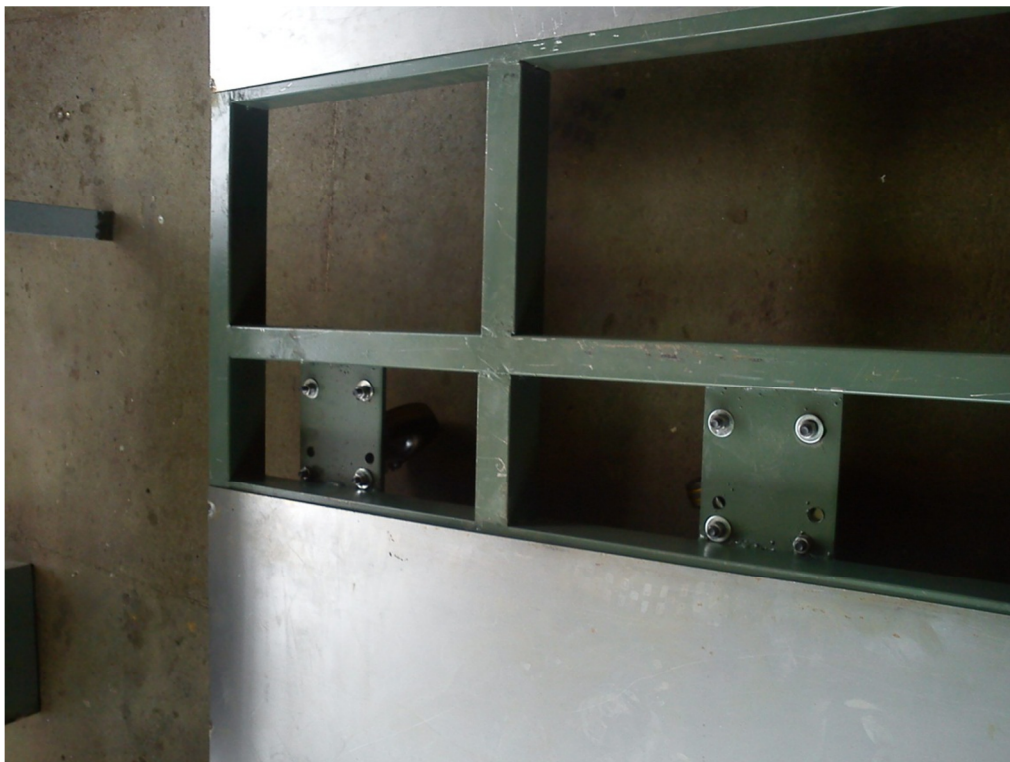
Figura - Execução de solda no SG-9.
