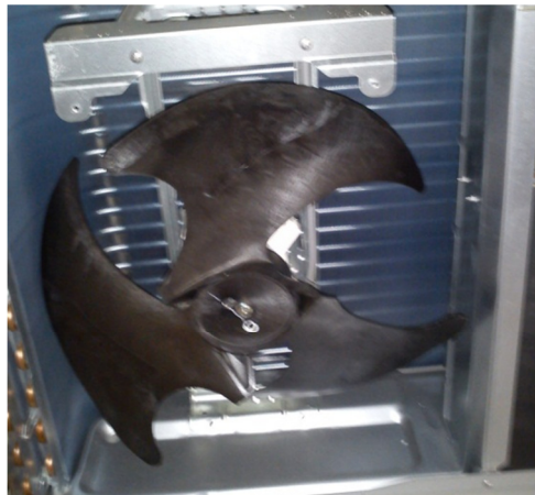
Figura 3.17 – Ventilador da Unidade Condensadora.
