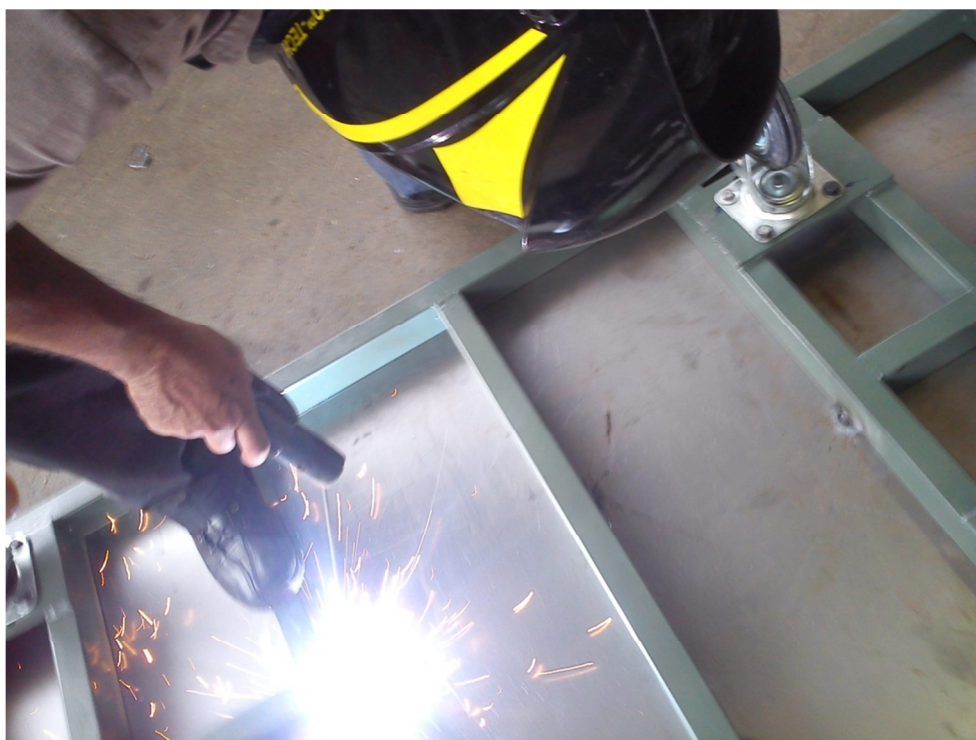
Figura - Solda de chapa para distribuir o peso sobre a estrutura.
