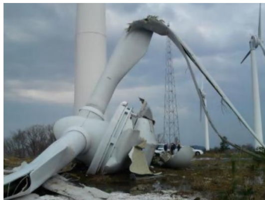
Figura 4 – Acidente com a nacele do aerogerador em Taikoyama. Fonte: (LIU, 2016).
