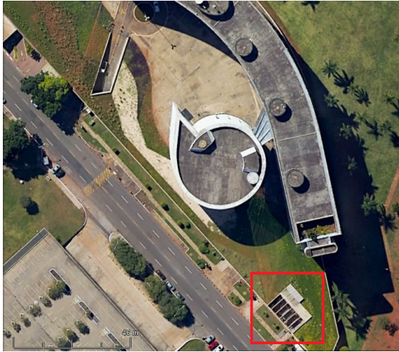
Figura 3.10: Imagem de satélite com localização da saída de ar das torres
