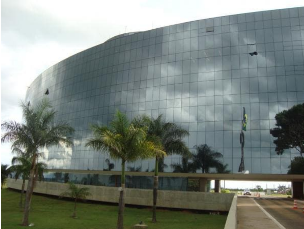
Figura 3.3: Fachada do edifício Anexo II, com vidros dotados de película reflexiva
