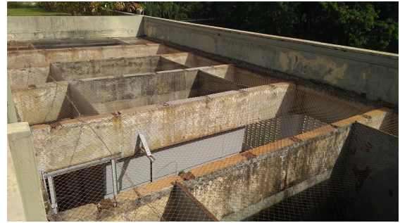
Figura 3.11: Área de saída de ar da torre
