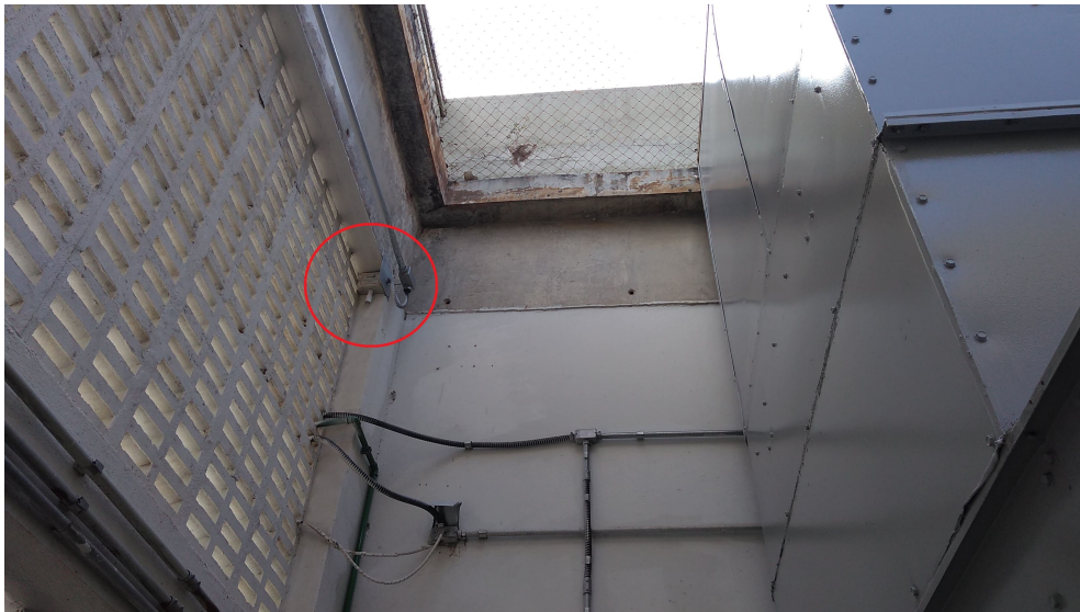
Figura 3.16: Sensor de temperatura e umidade relativa
