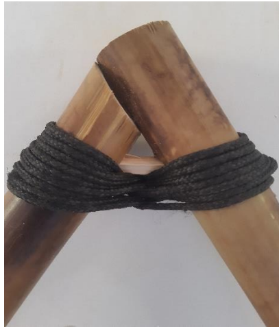
Figura 4. Detalhe do encaixe dos triângulos, corte, tarugo e amarração com corda. Fonte: Imagem capturada pelo autor em 2020.
