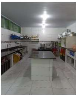
Figura 4 – Cantina após a reforma
