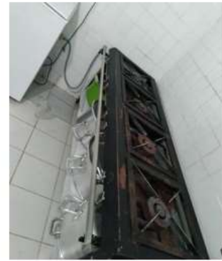
Figura 2 – Fogão utilizado antes da reforma
