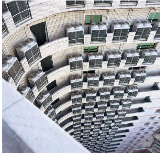
Fig. 3.18 - Edifício em Dailan, China - 1.753 TR com VRF (Rob Kuhlman, 2005)
