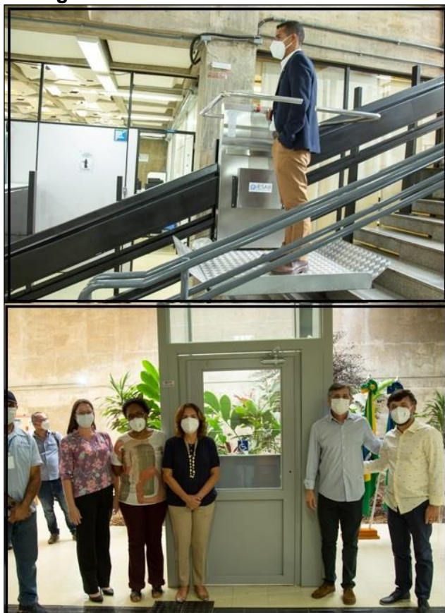
Figura 9: Obras de acessibilidade na FCI
