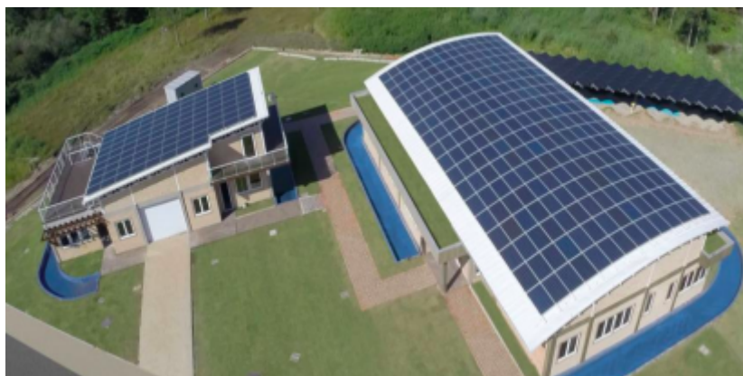
Imagem 3. Centro de Pesquisa e Capacitação em Energia Solar da UFSC. Fonte: google earth.
