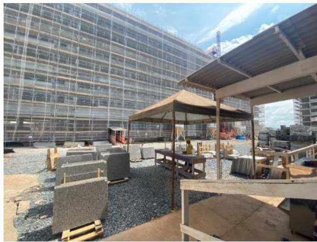
Figura 20 - Região na obra de armazenamento de granito e mesa de furação. (Fonte: Acervo pessoal)
