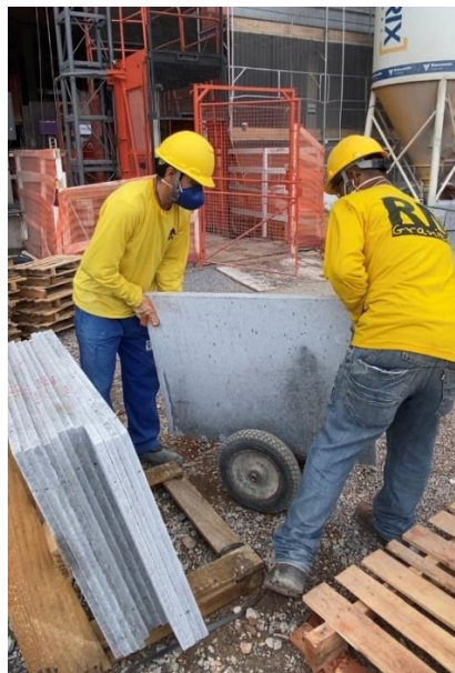
Figura 23 - Desmonte do pallet de granitos e transporte unitário de peças para a cremalheira. (Fonte: Acervo Pessoal)
