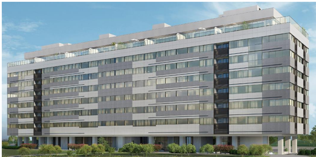
Figura 18 - Vista da fachada da edificação em que foram feitas as primeiras análises do trabalho. (Fonte: Incorporadora)
