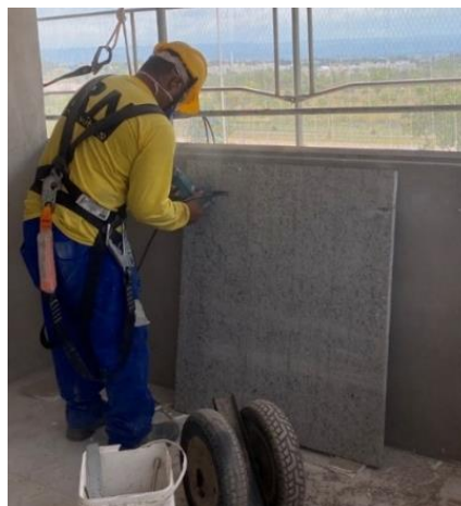
Figura 25 - Corte da peça de granito no interior da edificação. (Fonte: Acervo pessoal)
