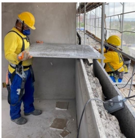
Figura 26 - Apoio da peça de granito no contramarco. (Fonte: Acervo pessoal)
