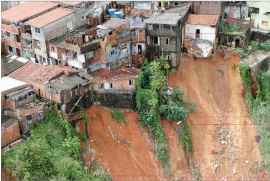
Figura 4 – Deslizamento de Terra em uma Zona Urbana do Espírito Santo (Santos, 2020).
