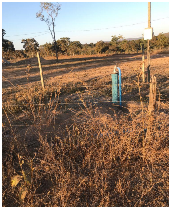
Figura 6-5 Poço tubular localizado na Subárea XI do Projeto Unai 2020.
