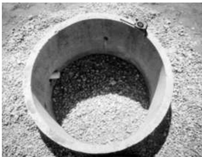
**Figura 6.5:** *Caixa de infiltração preenchida por cascalho (Cadamuro & Campos, 2005).*
