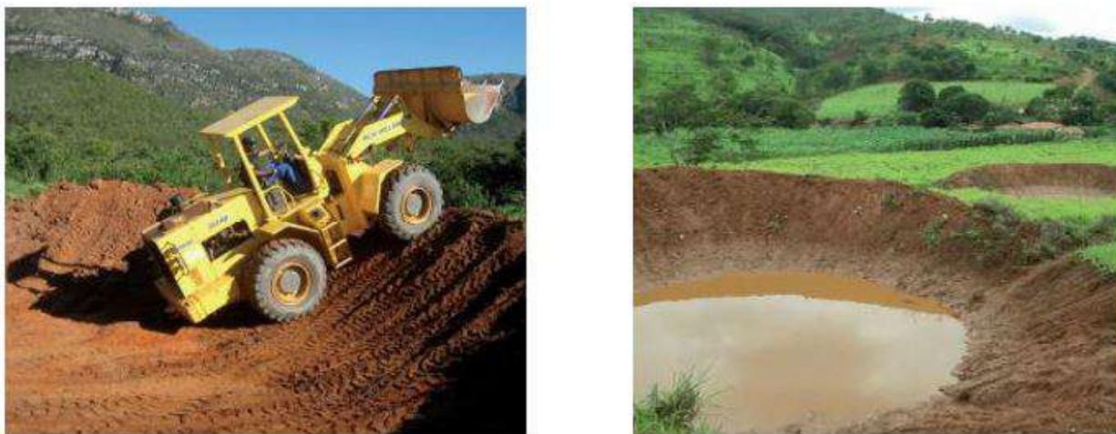
**Figura 6.4:** *A esquerda barraginha em construção utilizando pá-carregadeira e a esquerda barraginha já inundada (Barros et al. 2013).*
