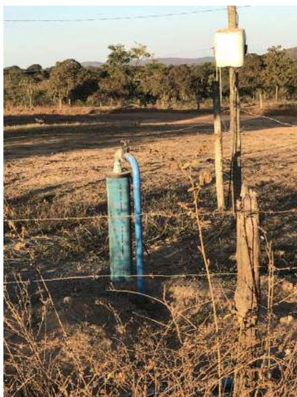
Figura 9.7: Poço tubular sem perímetro de proteção e não cadastrado no SIAGAS. Ponto de coordenadas UTM SIRGAS 2000 Zona 23S 297549 E 8144323 N. Imagem cedida pela subárea XI do Projeto Unaí.
