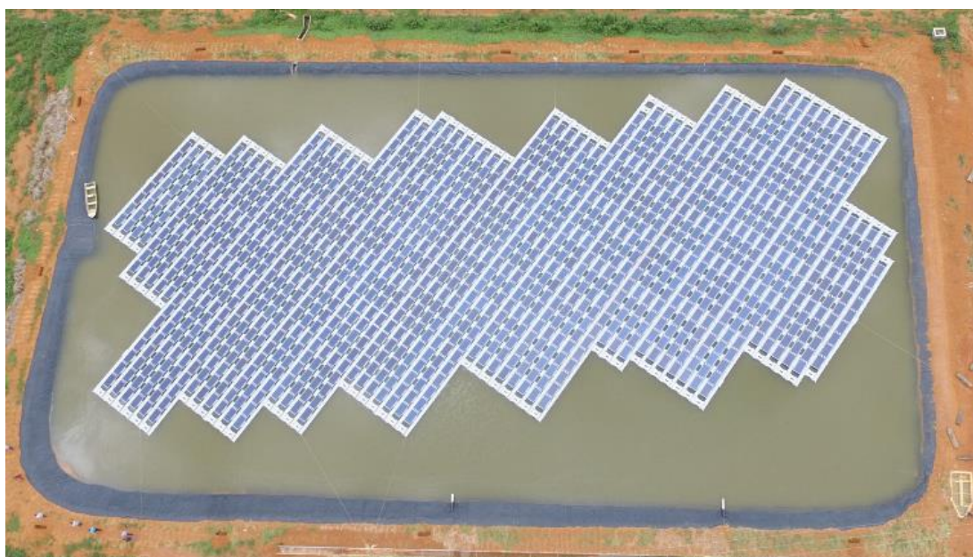
Figura 4.7 - Usina fotovoltaica flutuante implementada em Cristalina – GO e analisada no 2º caso
