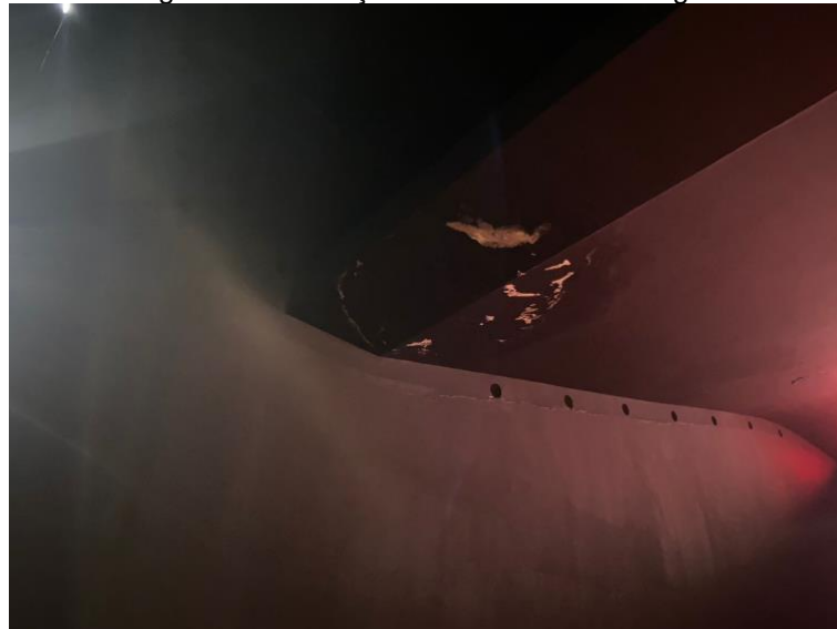
Figura 23: Infiltração no teto do Salão Negro.
