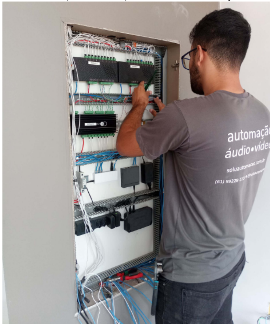
Figura 3.11 – Quadro do pavimento superior durante a instalação dos módulos.
