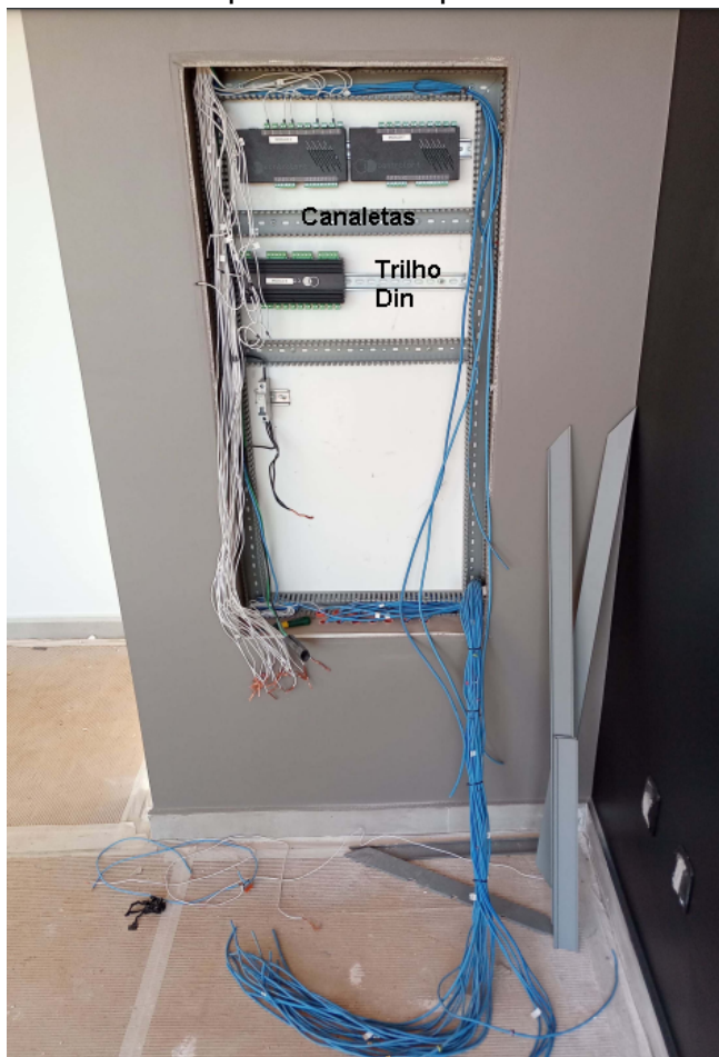
Figura 3.8 – Quadro do pavimento superior durante a montagem.
