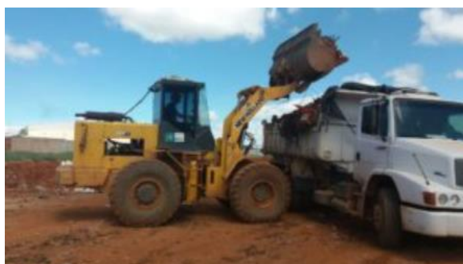
Figura 4.8 – Coleta mecanizada de RCC
