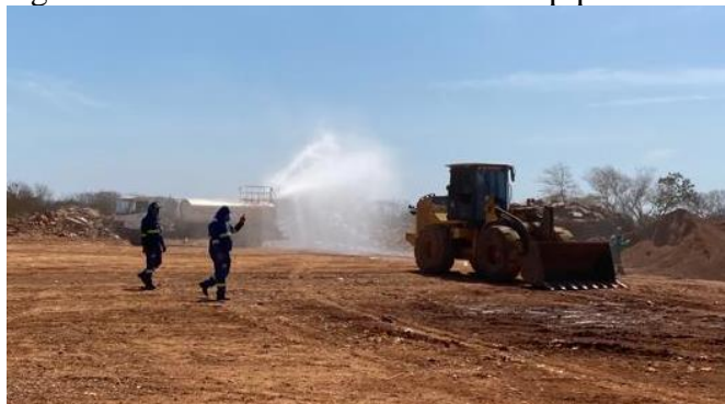
Figura 4.17 – Escavadeira e caminhão-pipa ao fundo
