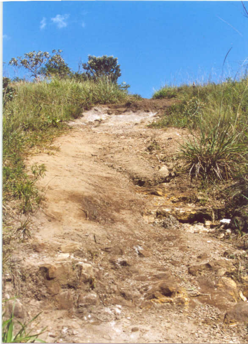
Figura 7 Erosão em Trilha no Parque Ecológico e Vivencial do Recanto das Emas no Distrito Federal Foto: Clodir de Matos (2003)
