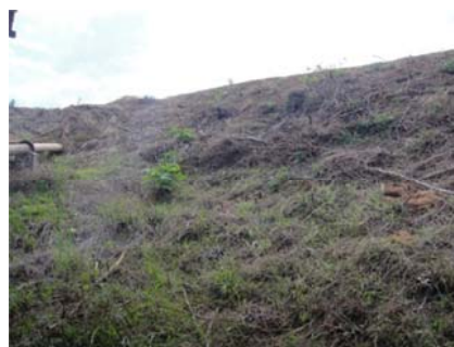
FIGURA 23 vista do talude jusante
