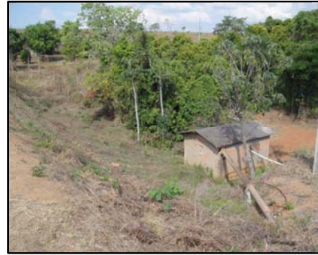
FIGURA 16 Casa de bombas
