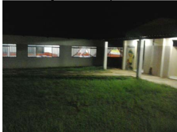
Figura 1 - Fachada do Colégio Estadual Ulysses Guimarães
