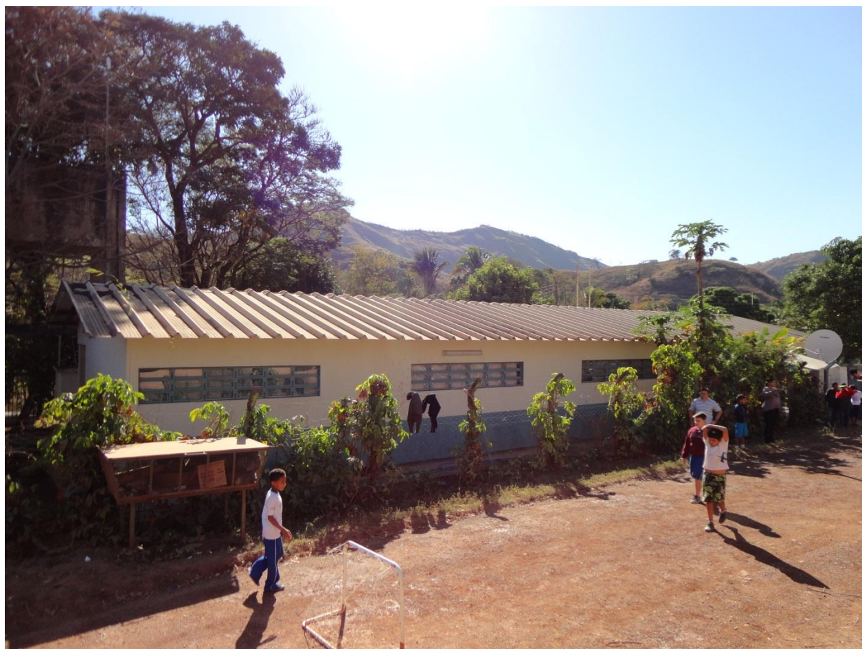
Área externa da Escola Classe Catingueiro – Agosto de 2014.
