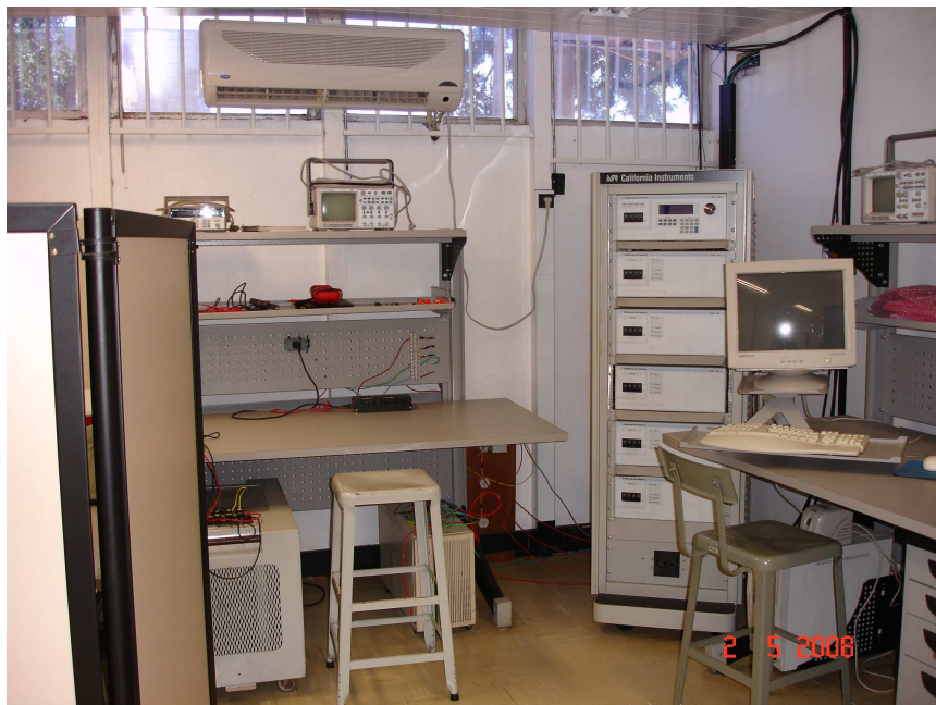
Figura 3.1 – Laboratório de Qualidade de Energia Elétrica.
